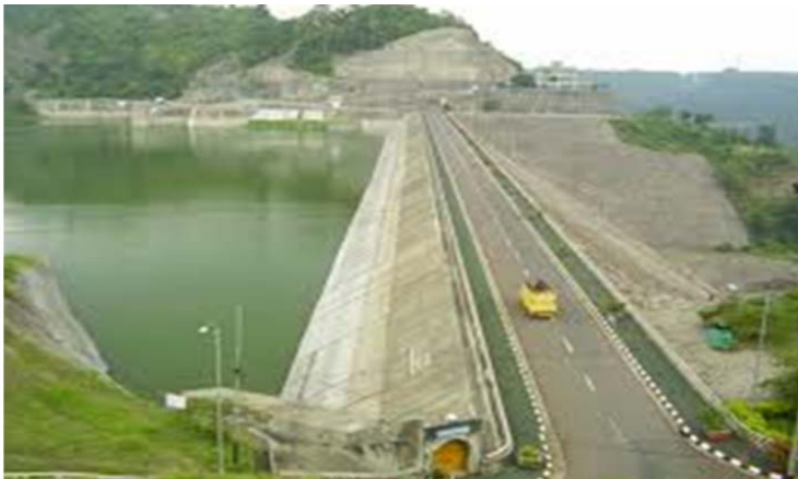
Gambar No. 5 - Bendungan PLTA Cirata (1000 MW), Tipe Reservoir Hydropower, Operasional untuk Pemasok Beban Puncak
