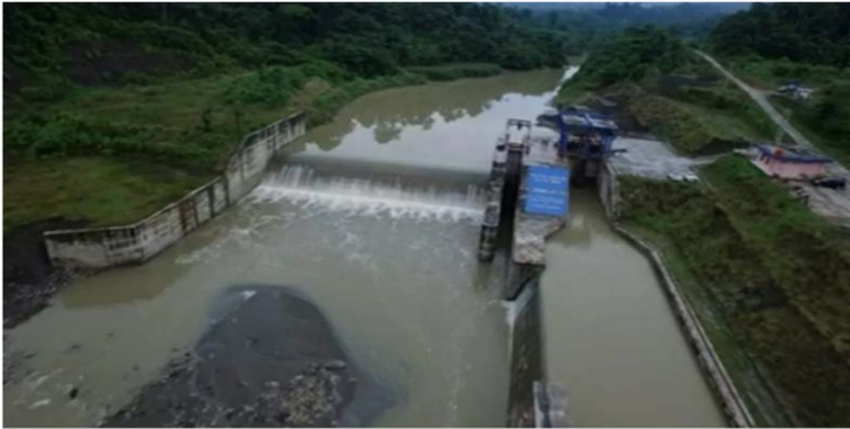
Gambar No. 4 - Bendung PLTA Oray Genyem Papua (20 MW), Tipe Run Off Hydropower, Operasional untuk Pemasok Beban Dasar
